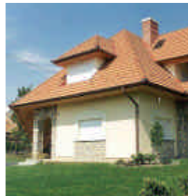
2000-es években épült tégla/pórusbeton ház:
